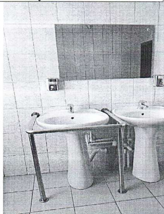
Фото №17 «Туалетная комната»
