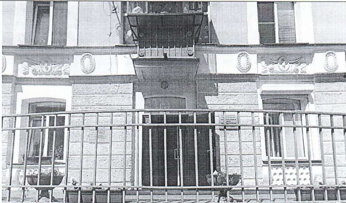
Фото № 8 «Входная площадка (перед дверью)»
